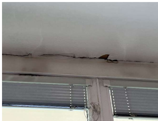
Foto č. 12 – trhliny v nadpraží okna
