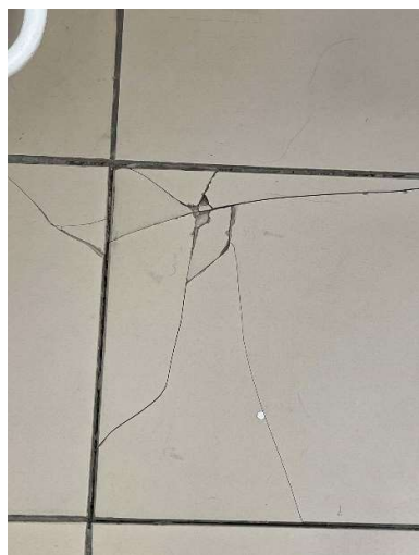
Foto č. 9 – poškozená dlažba
