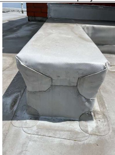
Foto č. 12 – neodborné provedení spoje
