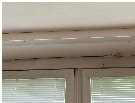
Foto č. 16 – trhliny v nadpraží okna
