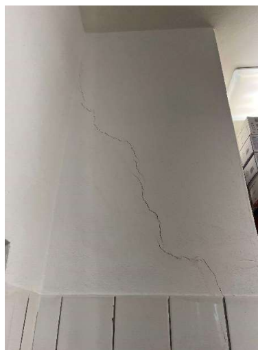
Foto č. 10 – trhlina stěna (m.č.601)
