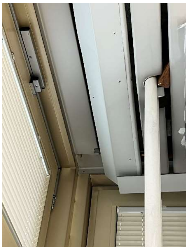
Foto č. 7 – podhled brání úplnému otevření
