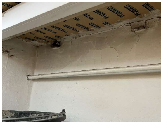
Foto č. 15 – síť trhlín v parapetu okna
