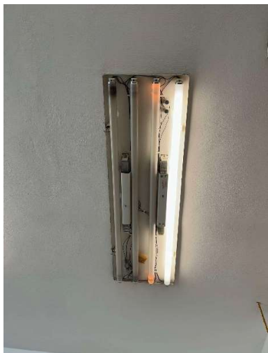
Foto č. 13 – chybějící kryt světla
