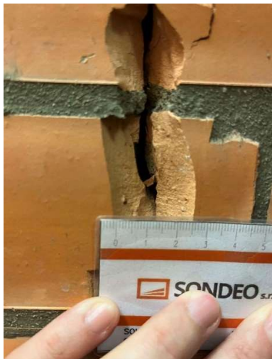
Foto č. 23 – trhlina obklad, schodiště
