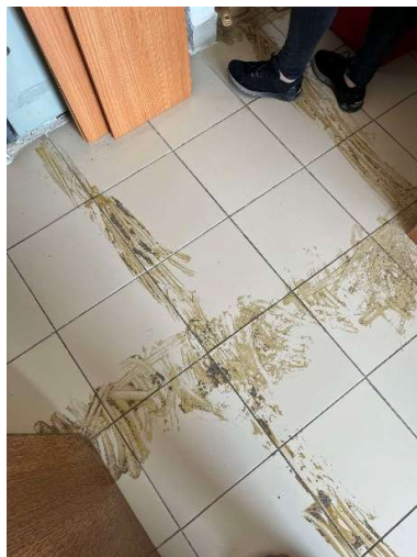
Foto č. 14 – špinavá dlažba, od lepidla (m.č.620)
