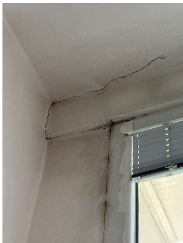
Foto č. 13 – trhliny v nadpraží a ostění okna
