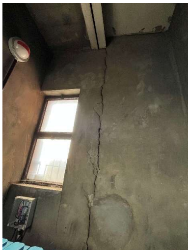
Foto č. 21 – trhlina stěna/podlaha (m.č. 805)
