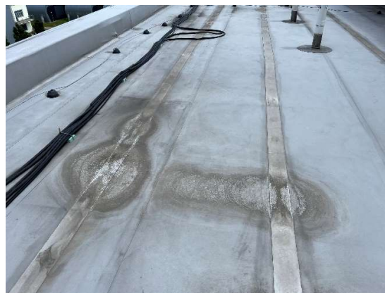
Foto č. 8 stopy kaluží od srážkové vody
