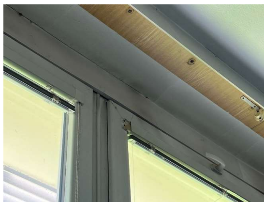
Foto č. 10 – trhliny v nadpraží okna
