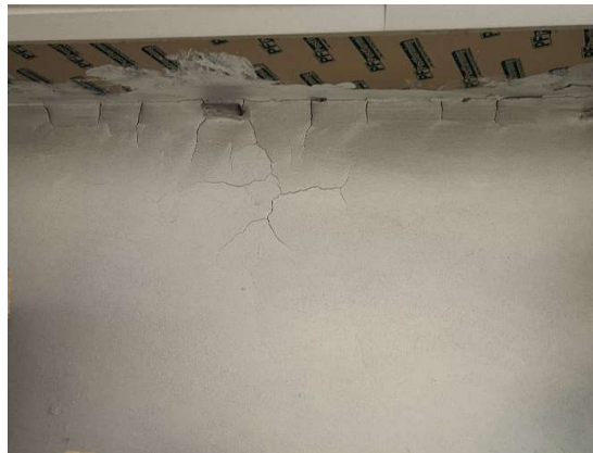
Foto č. 14 – trhliny v parapetu okna
